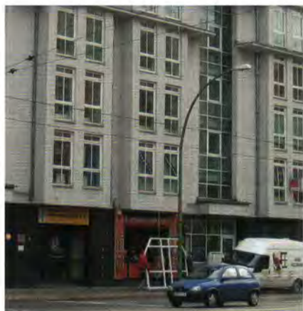
Ob Reparatur oder Austausch: Ein Handwerks- und Montagebetrieb muss stets die für den Kunden passende Lösung finden und effizient umsetzen.
